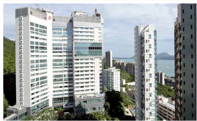
▲ 降低 T 座的窗牆比例以減少從室外到室內的熱量傳送
