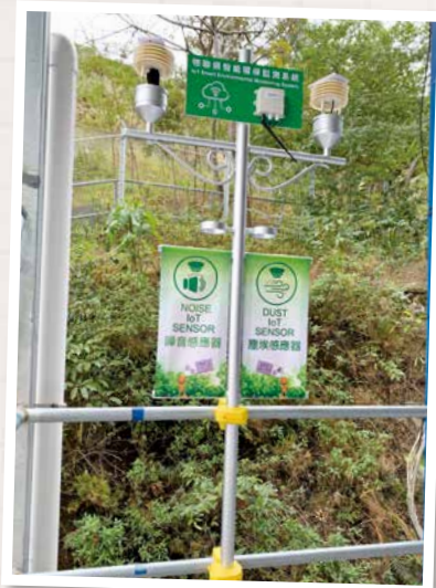
▲ 噪音及塵埃的物聯網感測器
